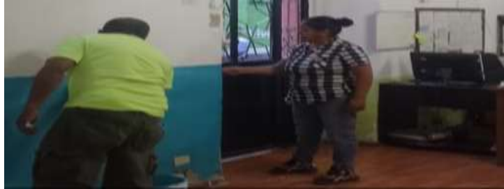
REALIZANDO MANTENIMIENTO A LAS PAREDES DEL INSTITUTO
