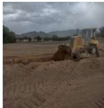
Desazolve de presa o tanque principal de la comunidad de El Durazno.
