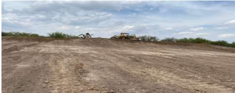
Desazolve de presa o tanque principal de la comunidad de Coyotillos.
